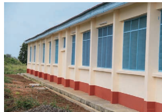
Unterrichtstrakte | Classroom wing
